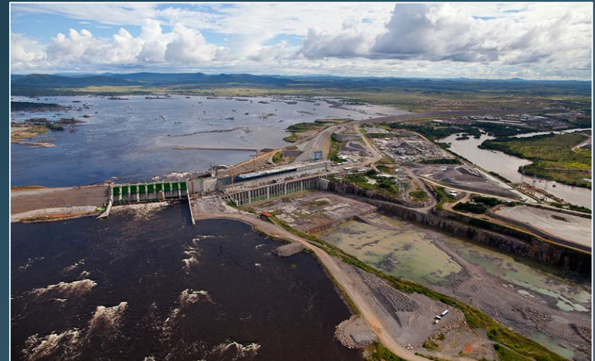
Represa Tocomá (en construcción)
